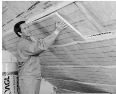
Untersparren-Dämmung
