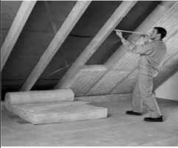
Zwischensparren- Dämmung
