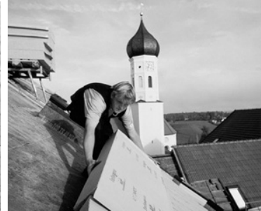
Aufsparren-Dämmung
