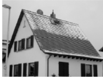
Dämmen im Steildach 4
